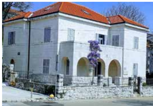
Zgrada Gradske knjižnice „Don Mihovil Pavlinović“ u kojoj se intenzivno provodi projekt imotskog iseljeništvu u Belgiji i gdje se održava izložba. Prikaz zgrade nakon temeljite obnove sredstvima Ministarstva kulture i medija. Foto: Marija Jović
