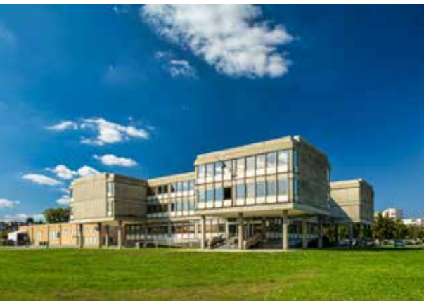
Zgrada Državnog arhiva u Karlovcu prije početka preseljenja i cjelovite obnove, listopad 2025. Foto: Denis Stošić
