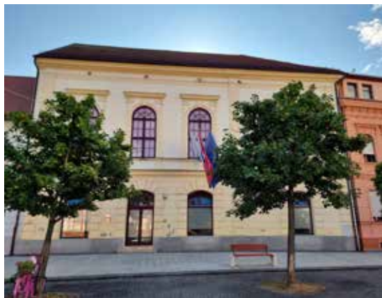
Zgrada Scheier, srpanj 2025.
