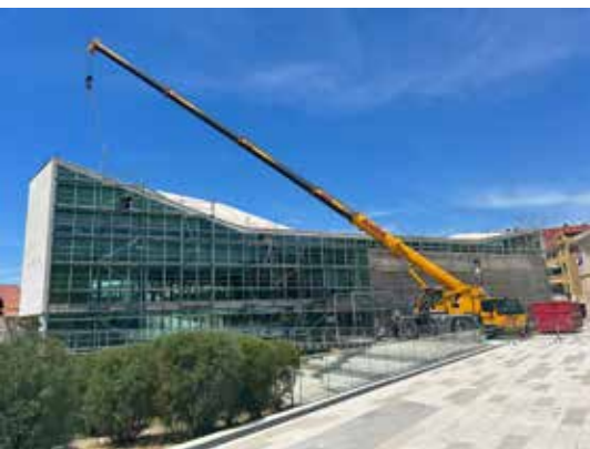
Gradska knjižnica „Juraj Šižgorić“ Šibenik tijekom energetske obnove Foto: Danijela Grubišić
